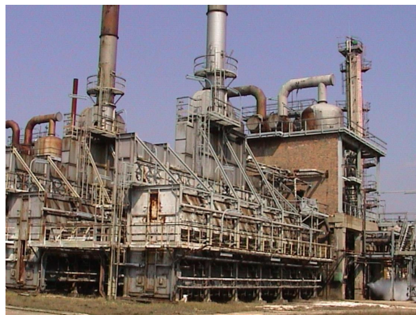
Rys. 2 Piec do syntezy CS 2 przed modernizacją
