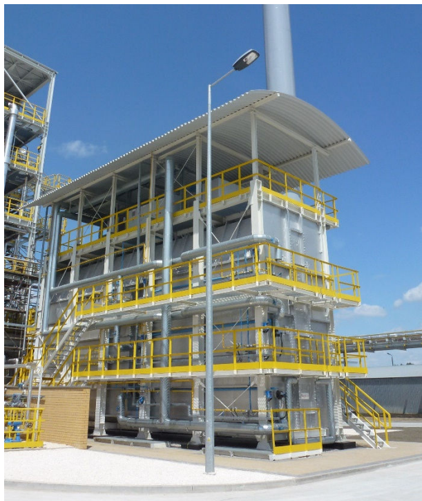
Rys.1 Piec do odparowania ciekłej siarki
