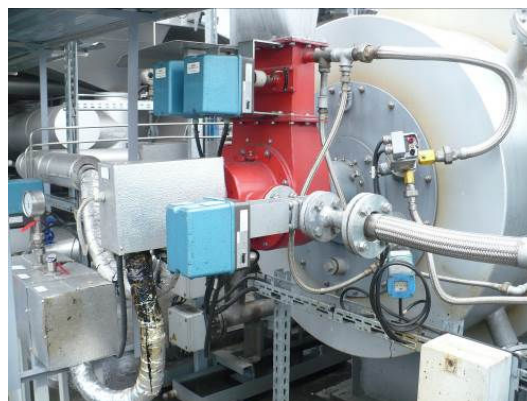
Palnik gazowo-smołowy z zapalarką i nadzorem płomienia
