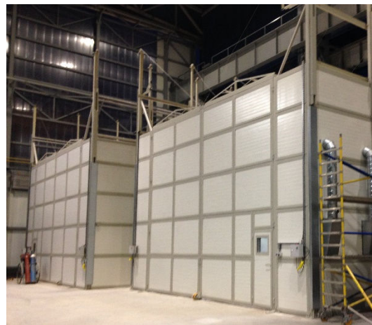
Widok na kabiny upalania nadlewów
